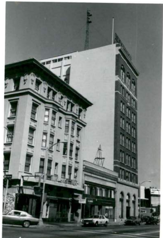
144/6A 1601-25 Clay St.: Hotel Wagner, Lavenson Bldg, P.G. & E. Bldg.
