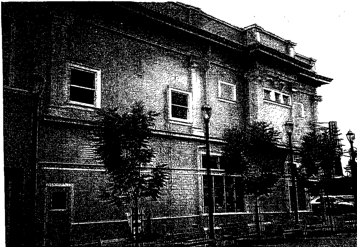
34 th Avenue/Avenida De La Fuente view
